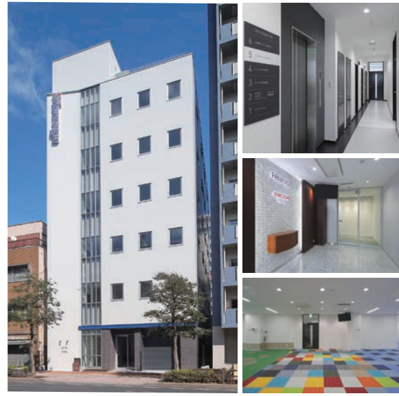
久永情報マネジメント株式会社新本社ビル
