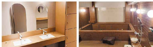
屋上防水、外壁改修、6～7F客間改修
